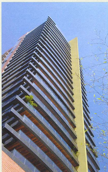
Varandas ocupam a porção frontal do edifício
