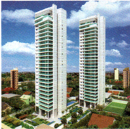
Torres desalinhadas e afastadas para preservar vista para a rua
