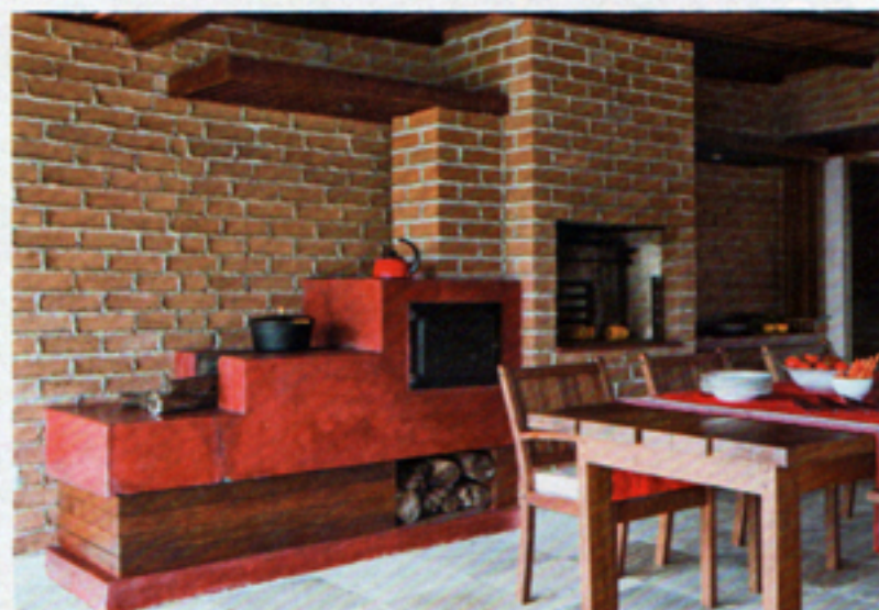
As paredes de tijolos chamam a atenção com o assentamento de juntas desencontradas e argamassa transbordada: "É como o recheio de um sanduíche", explica o arquiteto.
